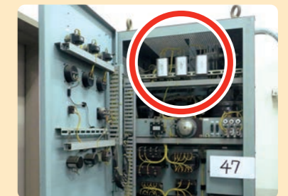
可変周波数電源装置に取り付けられた低圧コンデンサー
