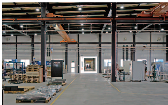
本年竣工した第 1、第 2 新工場 作業効率を追求して第 1・第 2・第 3 工場が一直線で結ばれている
