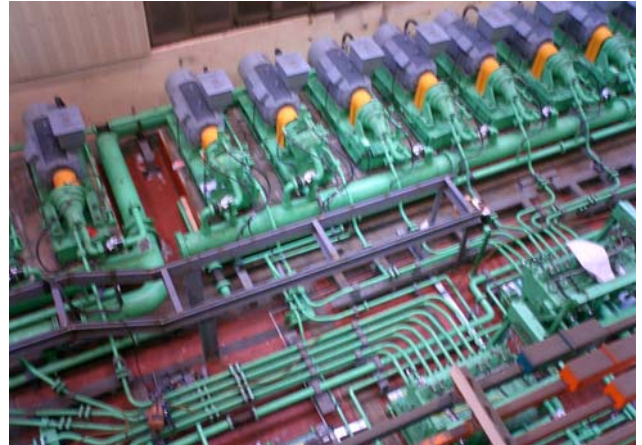
図13. 油圧ユニット
