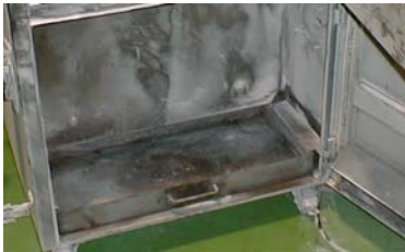
焼損後の集塵機内部状態
