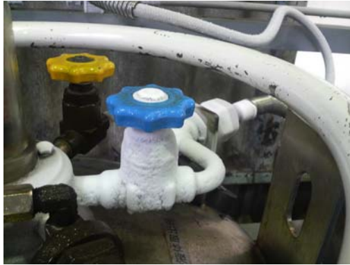
図 53. 凍結した配管・バルブ
